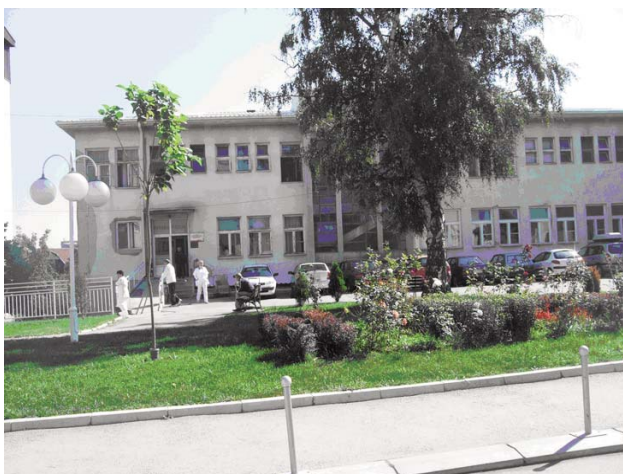
Slika 2. Zgrada ortopedске službe od 1973.godine
